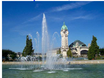
La gare de Limoges
